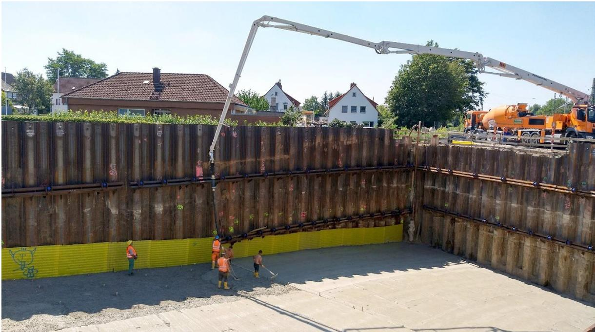
Die im Juli entstandene Aufnahme zeigt die Herstellung der Unterwasserbetonsohle im Bereich der Ladestraße. Die blauen Punkte in den Spundwänden markieren die Einbauorte der Erdanker.
