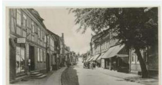
Unterteilte Holzsprossenfenster, Holzkassettentüren, tlw. Klappläden, Fachwerk, Backstein, Putz, gegliederte Schaufenster, typische Dachränder
