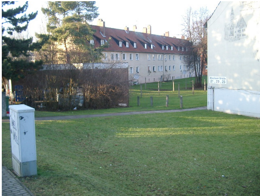
Blick von der Einmündung der Liegnitzer in die Breslauer Straße nach Nordwesten
