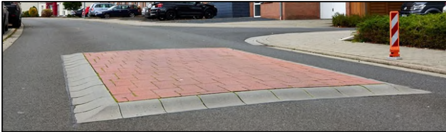
Abbildung 1: Plateaufpflasterung (Quelle: https://www.poetsch.de/strassen-verkehr/verkehrsberuhigung/produkt/plateau-aufpflasterung )
